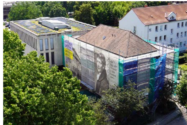
Sanierungsarbeiten am Altbau des Kleist-Museums, 2023 ©Stiftung Kleist-Museum
