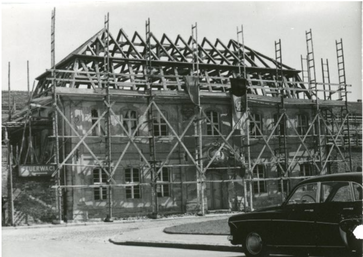
Umbau der Garnisonsschule in ein Museumsgebäude, 1967 ©Stiftung Kleist-Museum
